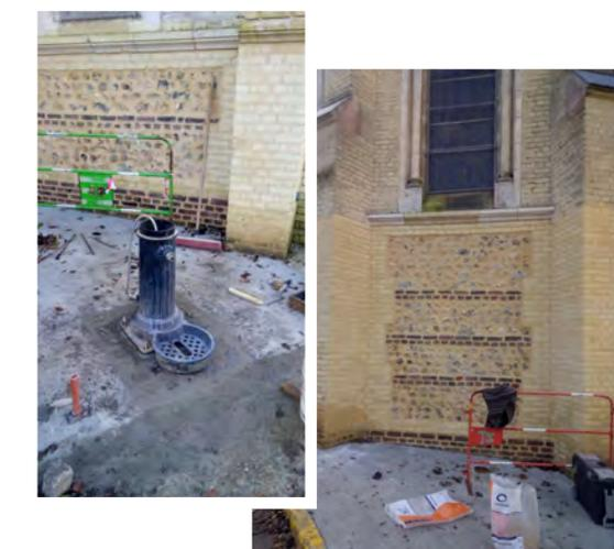
SOUS LE PORCHE d'entrée, l'enduit soufflé a été décapé, **les pierres anciennes** ont été ressorties pour être mises en valeur et la porte d'entrée réparée.
